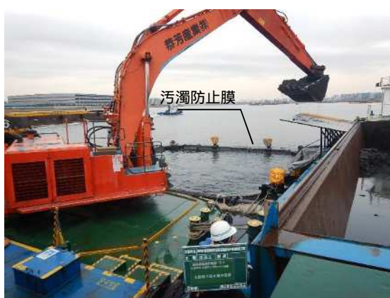
図 2.2.20 汚濁防止膜設置状況 (浚渫時)
