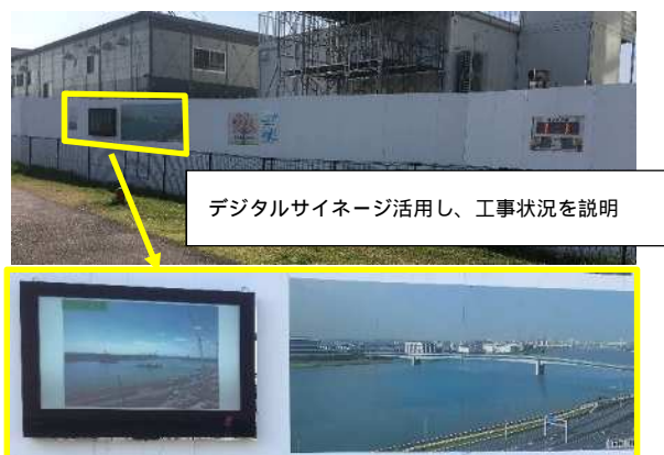
図 2.2.38 電光掲示板による説明状況 (多摩川サイクリングロード沿い)
