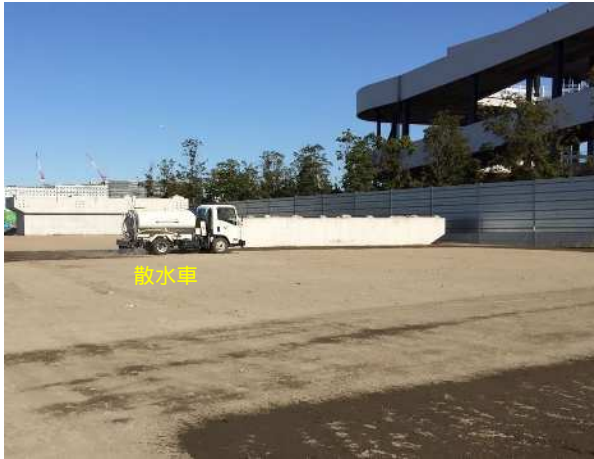
図 2.2.36 散水車による散水状況
