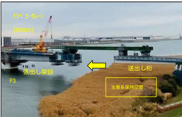
右岸側 張出し・送出し架設
