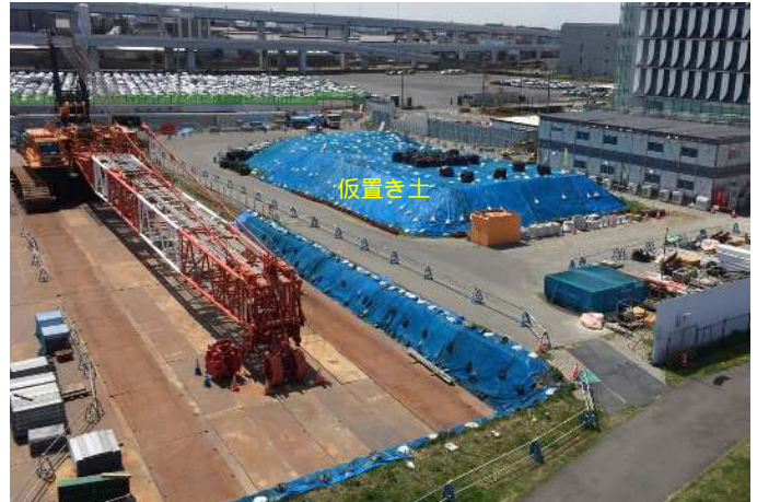
図 2.2.37 仮置き土ブルーシート養生
