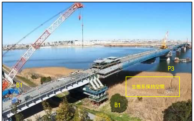
右岸側 側床版架設
