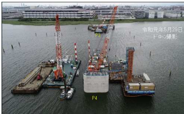
橋脚躯体コンクリート完成
