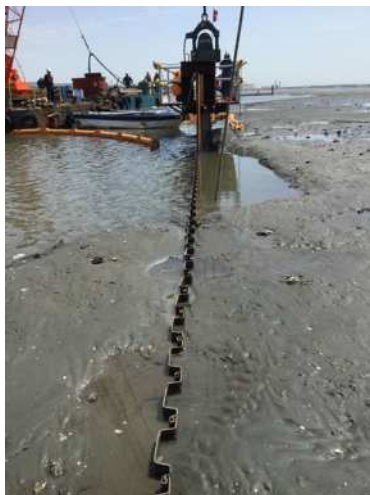
図 2.2.15 生態系保持空間の保護(仮設鋼矢板設置)の実施状況
