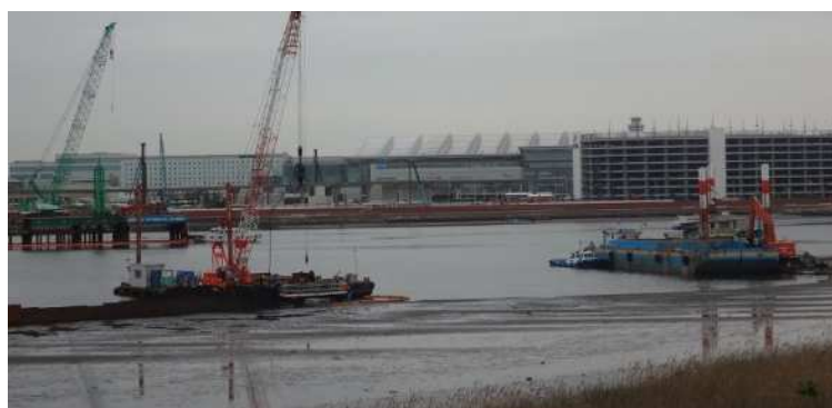
図 2.2.14 築造部浚渫状況
