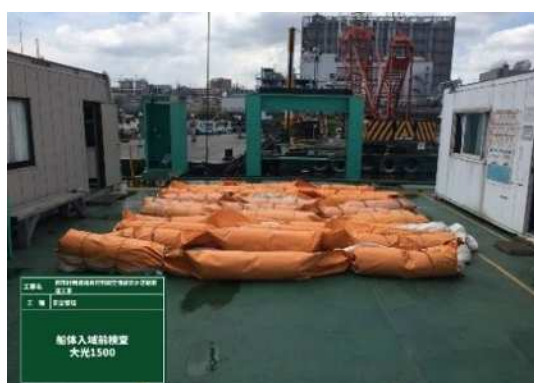
図 2.2.25 オイルフェンス常備状況
