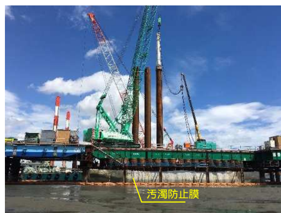
図 2.2.21 汚濁防止膜設置状況 (鋼管矢板打設時)
