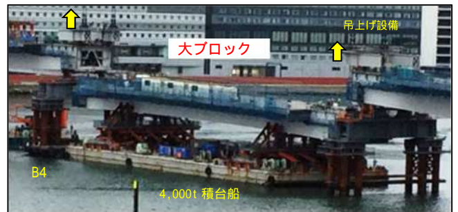
大ブロック一括吊上げ架設
