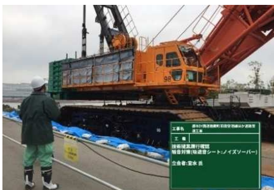
図 2.2.32 吸遮音シート設置
