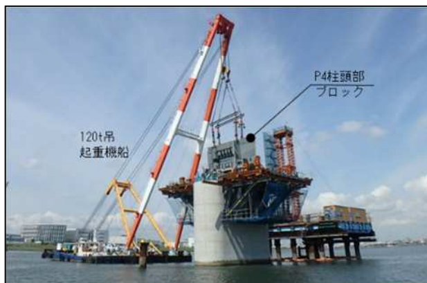
柱頭部 鋼桁据付
