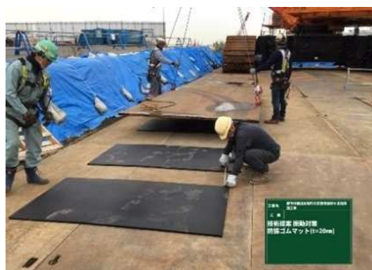
図 2.2.33 防振ゴムマット設置
