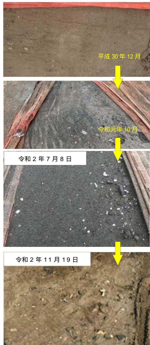
養生シート下の状態
