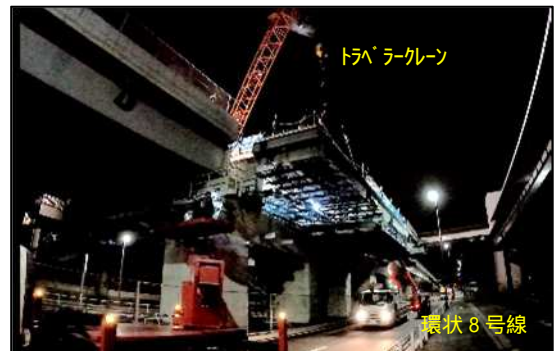
左岸側 張出し架設(夜間規制)
