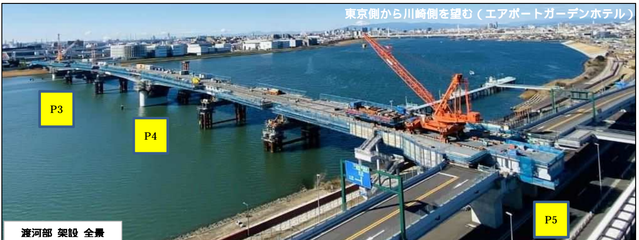
右岸側 張出し・送出し架設
