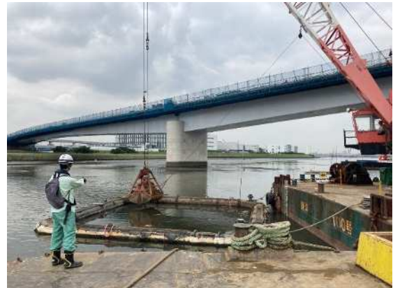
図 2.2.34 汚濁防止枠設置状況（埋戻時）
