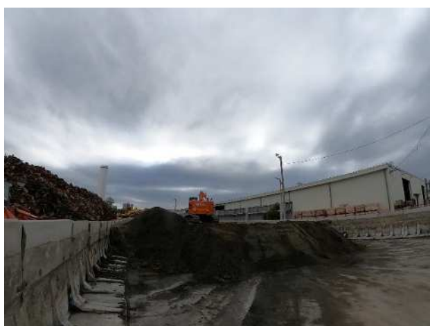
図 2.2.20 仮置き土砂搬出状況
