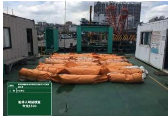
図 2.2.38 オイルフェンス常備状況
