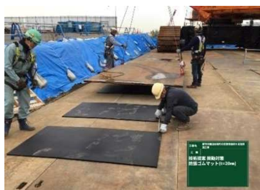
図 2.2.46 防振ゴムマット設置
