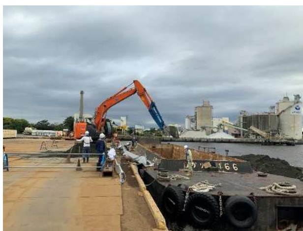
図 2.2.21 仮置き土砂積込状況
