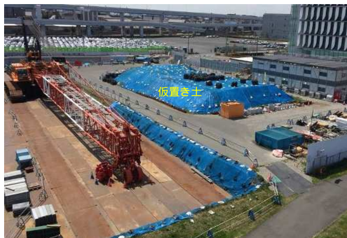
図 2.2.50 仮置き土ブルーシート養生
