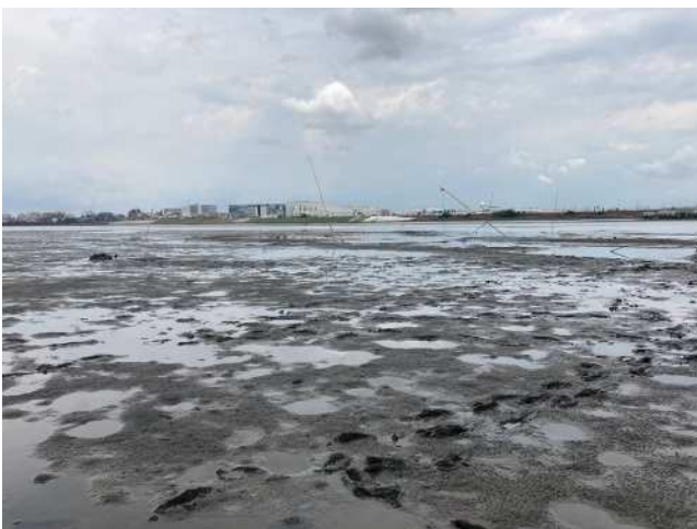
図 2.2.25 埋戻し完了全景
