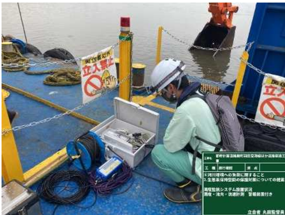
図 2.2.35 水質調査状況（埋戻時）
