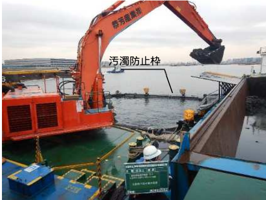
図 2.2.33 汚濁防止枠設置状況（浚渫時）
