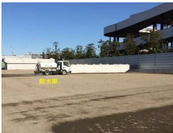
図 2.2.49 散水車による散水状況
