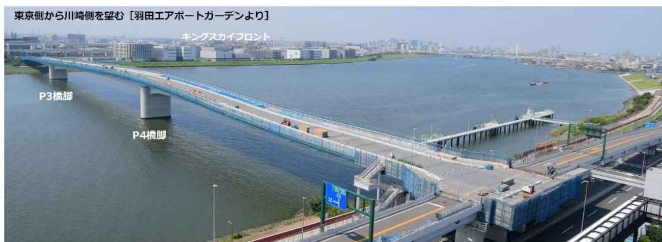
橋梁部地覆コンクリート実施状況
