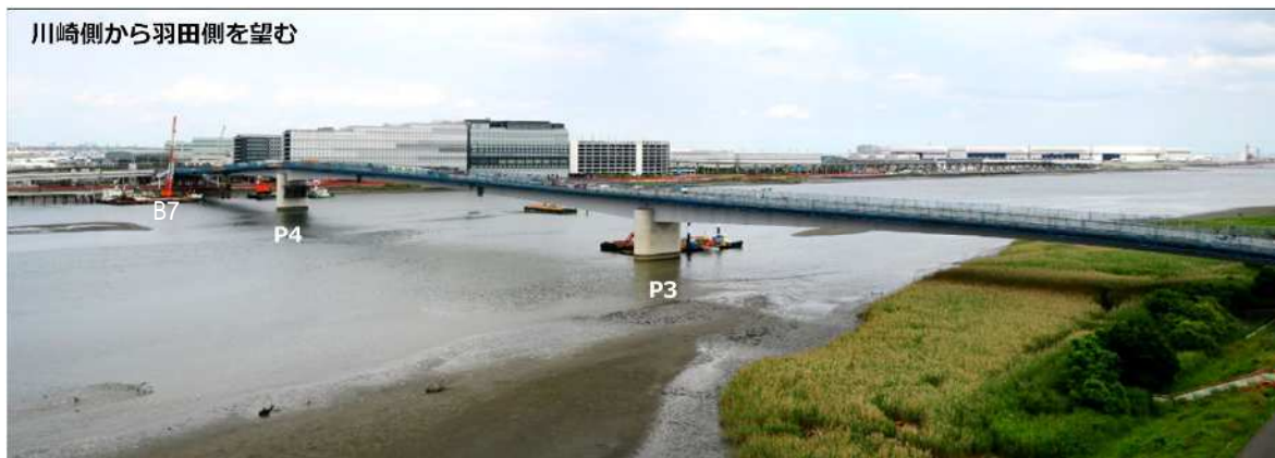
ベント設備（B7）撤去状況
