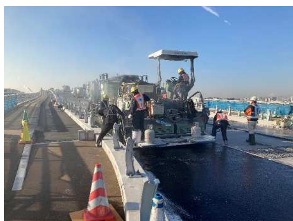
車道舗装状況
