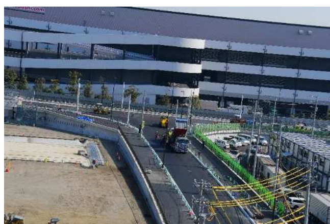
交差点部道路舗装状況
