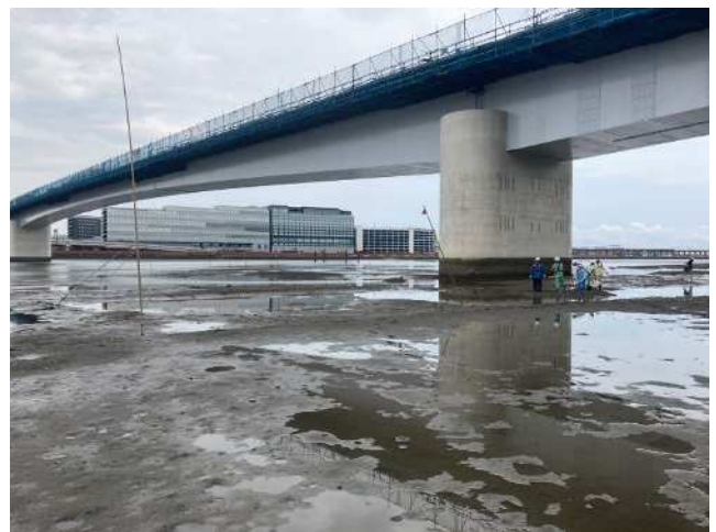
図 2.2.26 埋戻し完了全景
