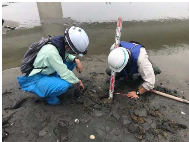
図 2.2.27 表土埋戻し確認状況
