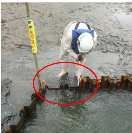
図 2.2.16 矢板打ち下げ状況(帯水対策)
