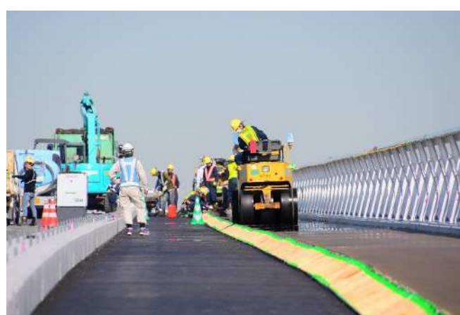
歩道舗装状況
