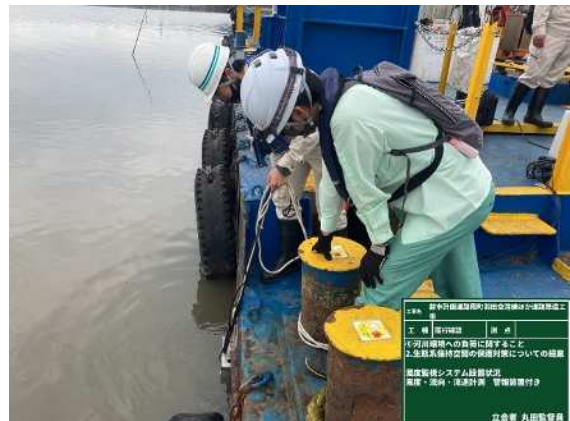
図 2.2.36 水質調査状況（埋戻時）
