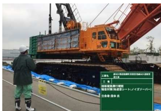
図 2.2.45 吸遮音シート設置
