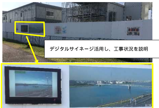
図 2.2.51 電光掲示板による説明状況(多摩川サイクリングロード沿い)
