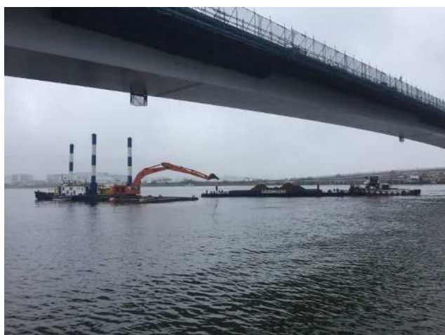
図 2.2.22 埋戻し土投入状況
