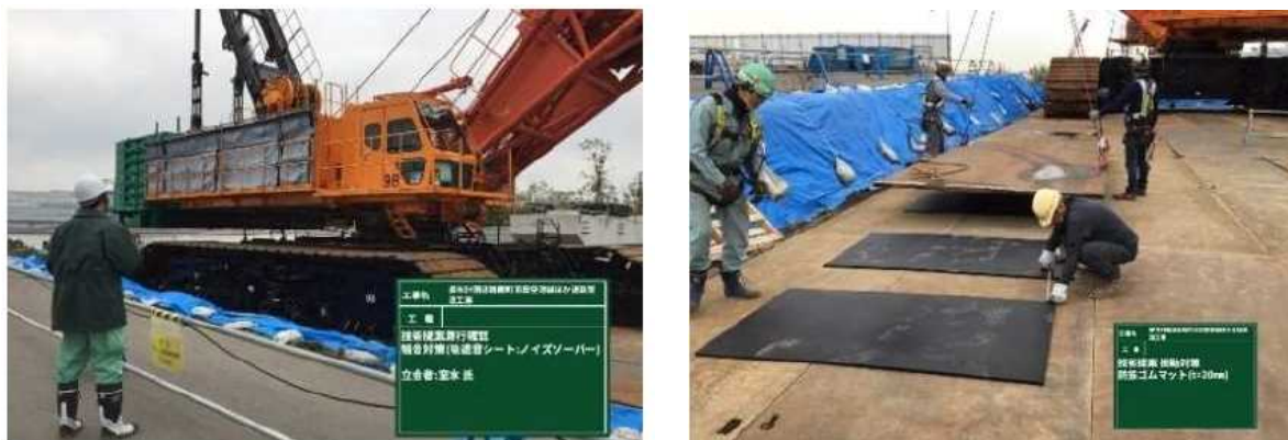
図 2.32 遮音シート（左）及び防振ゴムマット（右）の設置状況
