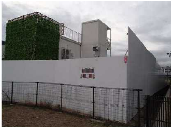
騒音振動計設置状況
