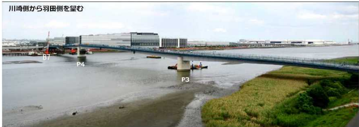
ベント設備（B7）撤去状況
