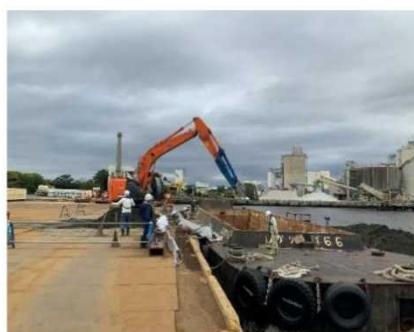
仮置き土砂積込状況
