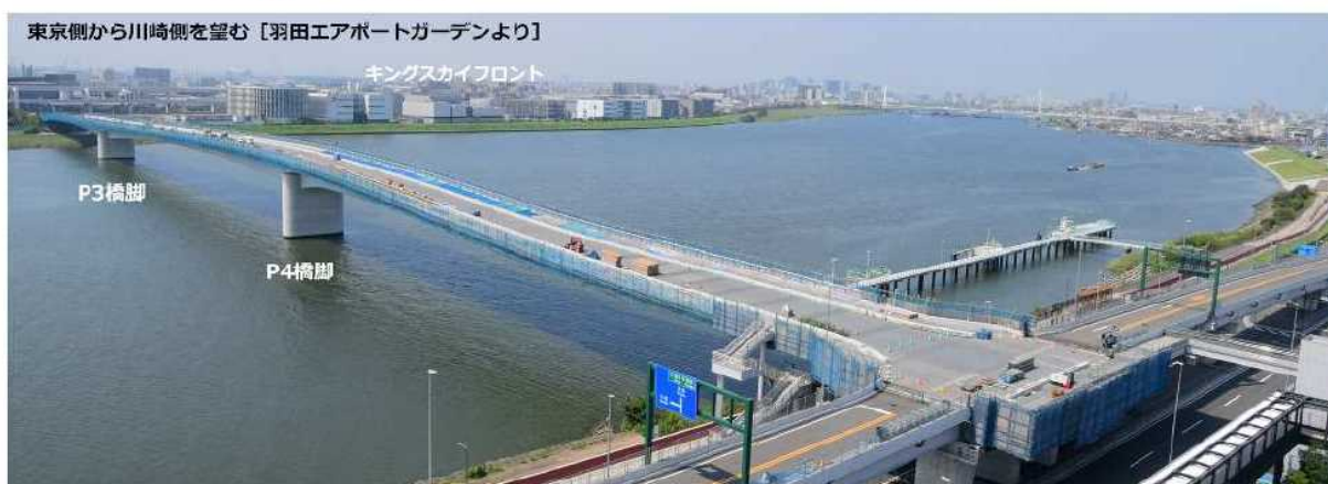
橋梁部地覆コンクリート実施状況
