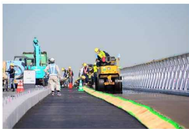
歩道舗装状況
