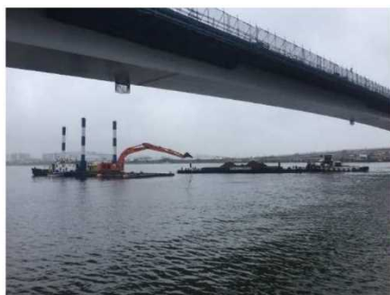
埋戻し投入状況
