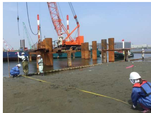
図 2.15 矢板打ち下げ状況 (帯水対策) (左) 及び緩衝帯地形変化確認状況 (右)
