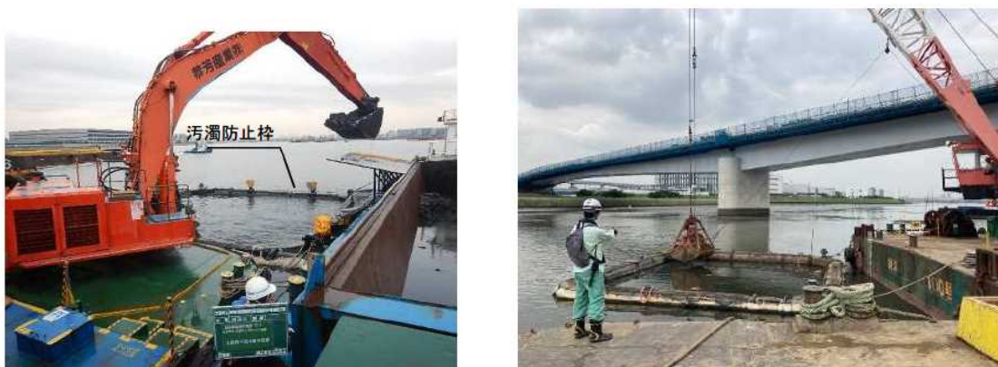
図 2.26 汚濁防止柵の設置状況（左：浚渫時、右：埋め戻し時）
