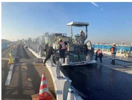
車道舗装状況
