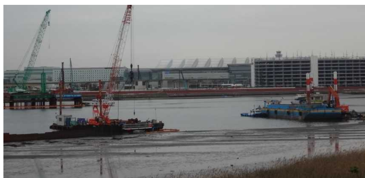
図 2.13 築造部浚渫状況
