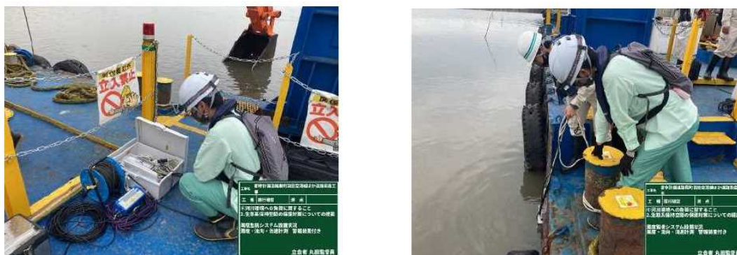
図 2.27 水質調査状況（埋め戻し時）
