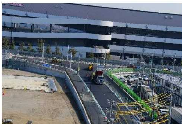
交差点部道路舗装状況
