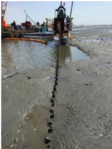
写真 2-11 生態系保持空間の保護(仮設鋼矢板設置)の実施状況
