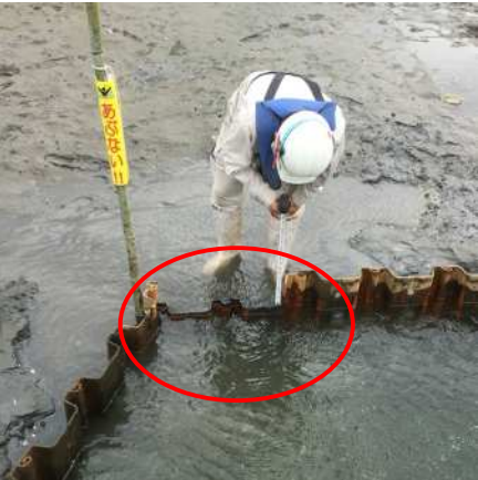
写真 2-12 実施状況 (左：矢板打ち下げ状況 (帯水対策)、右：緩衝帯地形変化確認状況)
