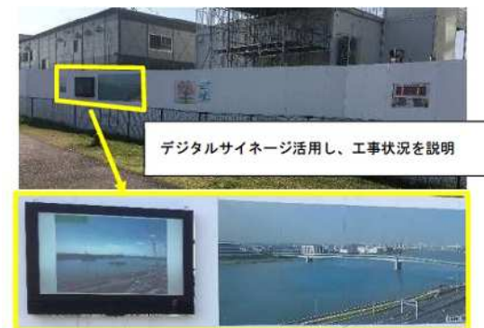
図 2-18 電光掲示板による説明状況（多摩川サイクリングロード沿い）
