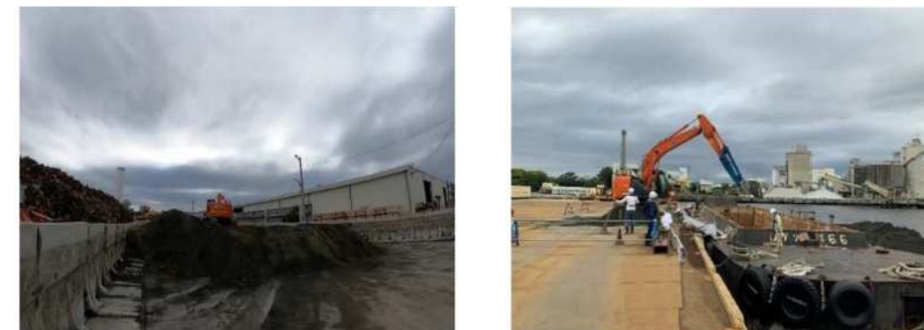
写真 2-17 処理状況 (左：仮置き土砂搬出状況、右：仮置き土砂積込状況)
