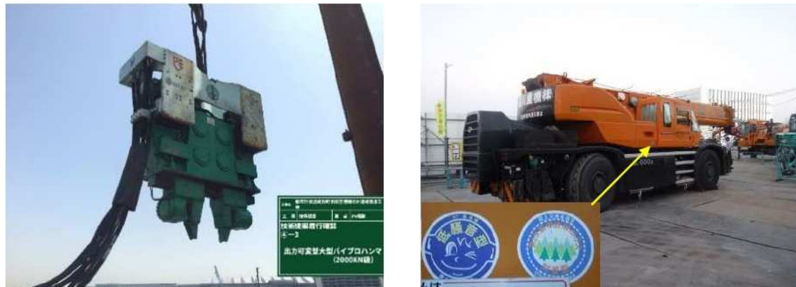
写真 2-26 建設機械（左：特殊バイブロハンマ使用、右：低騒音型建設機械）
