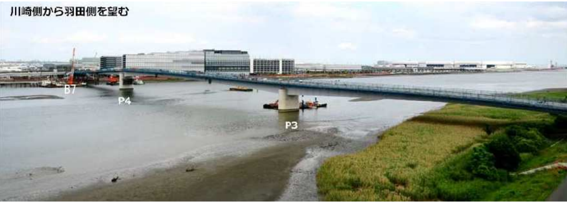
写真 2-1 ベント設備撤去状況
