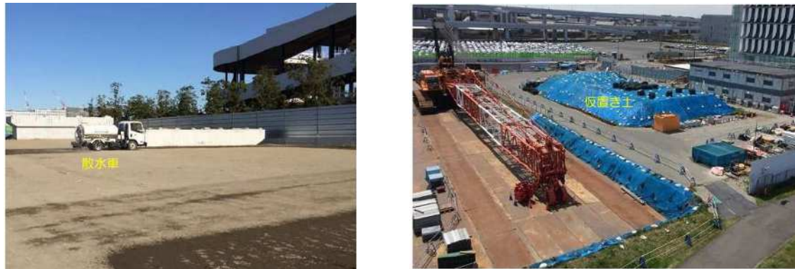
写真 2-30 粉塵対策（左：散水車による散水状況、右：仮置き土ブルーシート養生）
