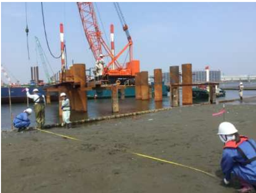
写真 2-12 実施状況 (左：矢板打ち下げ状況 (帯水対策)、右：緩衝帯地形変化確認状況)
