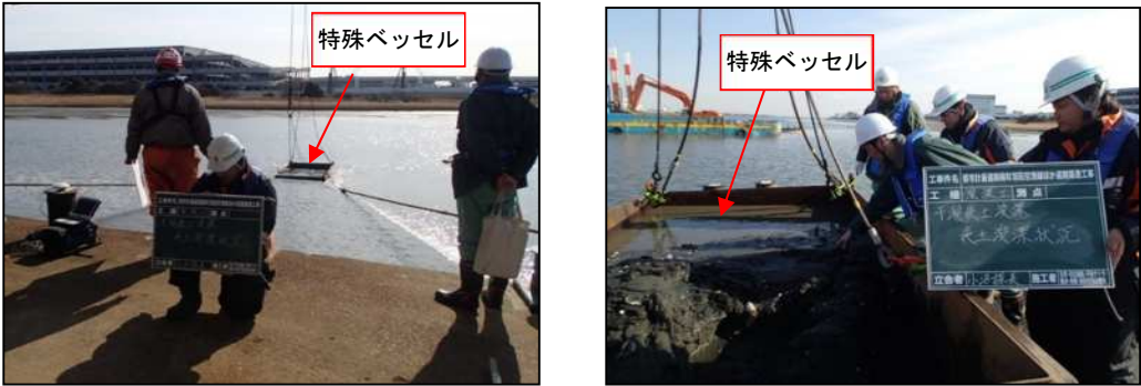
写真 2-13 実施状況(左：表土すき取り状況、右：表土すき取り後の確認)
