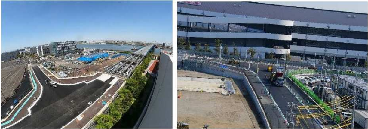
写真 2-4 （左：殿町側交差点部全景、右：交差点部道路舗装状況）
