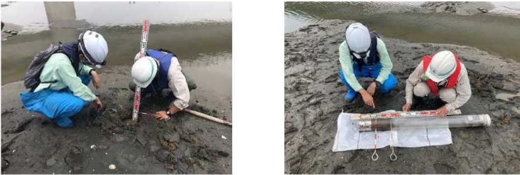
写真 2-20 表土埋戻しの確認状況
