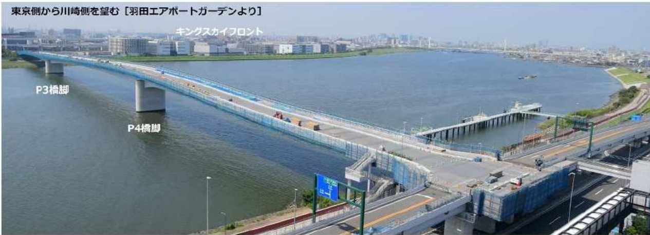
写真 2-5 橋梁部地覆コンクリート実施状況
