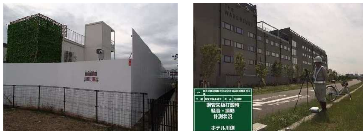
写真 2-27 騒音振動計設置及び計測状況（多摩川サイクリングロード沿い）
