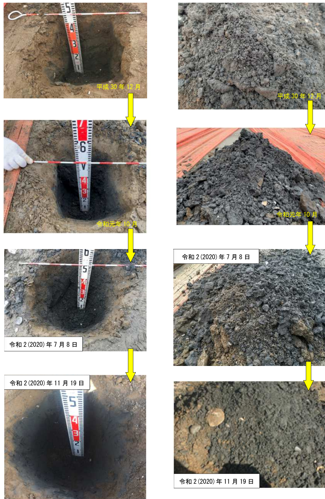
写真 2-16 干潟表土の状況(左：保管土の土中の状態 (約 0.5m 堀下げ)、右：保管土の状態)
