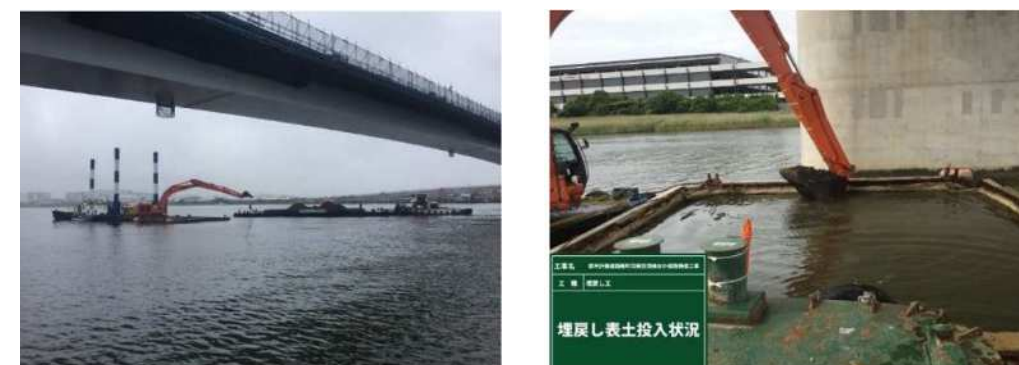
写真 2-18 処理状況 (左：埋戻し投入状況、右：表土投入状況)
