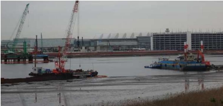
写真 2-10 築造部浚渫状況
