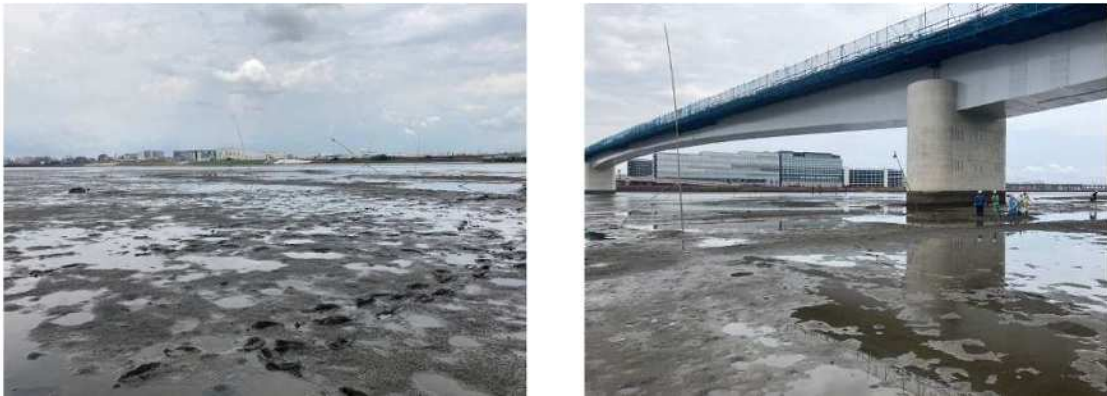
写真 2-19 埋戻し完了全景
