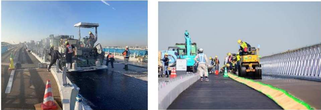
写真 2-6 （左：車道舗装状況、右：歩道舗装状況）
