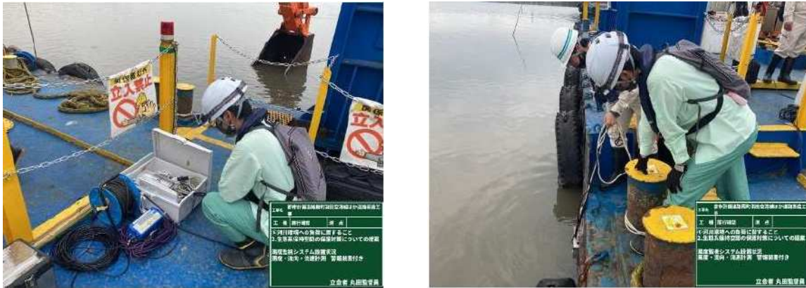
写真 2-23 水質調査状況（埋戻し時）
