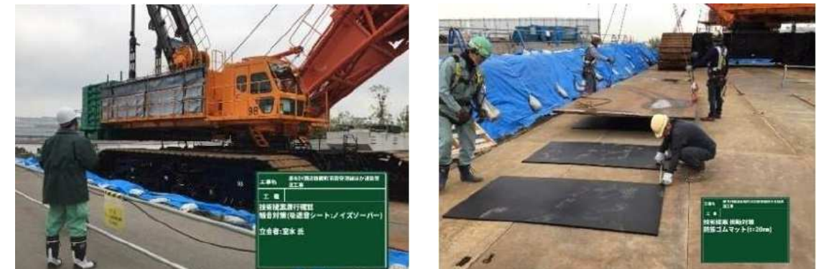
写真 2-28 騒音・振動対策（左：吸遮音シート設置、右：防振ゴムマット設置）
