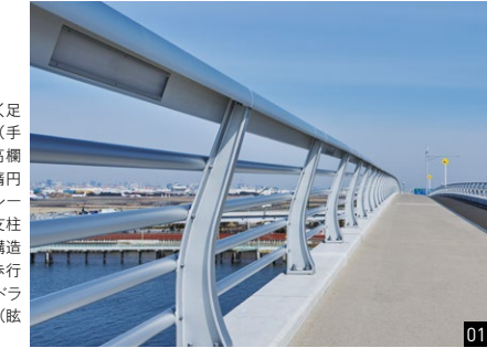
01 広く光が当たることなく足を照らす、トップレール(手すり)内蔵型の照明 02 高欄の高さは1.2m、幅広で楕円形のつかみにくいトップレール、歩道側に傾斜させた支柱など、よじ登りがしにくい構造に 03 全42か所に設置、歩行者を楽しませるサイン 04 ドライバーへ配慮した、グレア(眩しさ)対策
