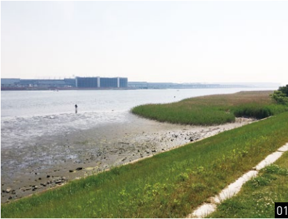
01 川崎側に広がる施工前の干潟 02 トラベラクレーン架設 03 送出し架設 04 干潟をまたぎ、環境を守りながら施工
