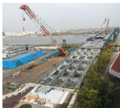
取付部施工状況
