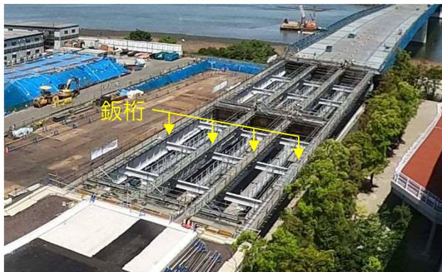
取付部施工状況(4月 鉄桁組立完了)
