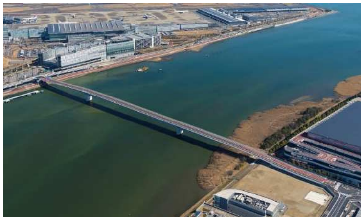
開通直前の多摩川スカイブリッジ全景（2022.2.28撮影）
