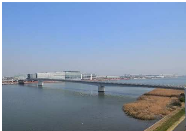
開通直前の多摩川スカイブリッジ全景（2022.3.11撮影）
