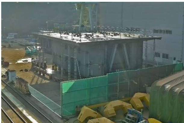
P4橋脚柱頭部の工場における仮組み立て確認
