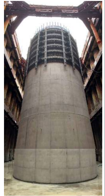
P4橋脚施工状況 (頂版から撮影)
