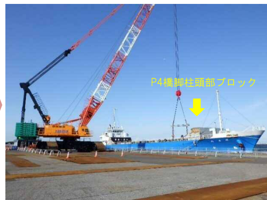
富津港にP4橋脚柱頭部ブロック到着
