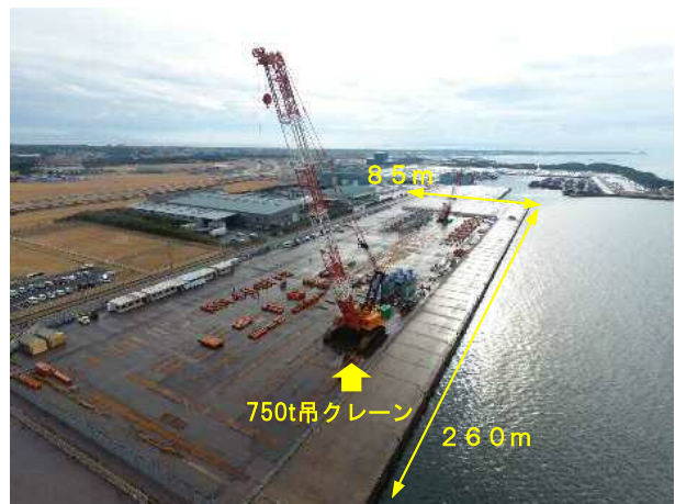
富津港地組ヤード全景
