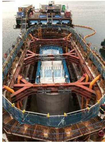
P4橋脚施工状況
