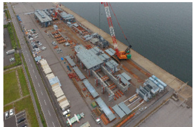
組立状況(富津市)
