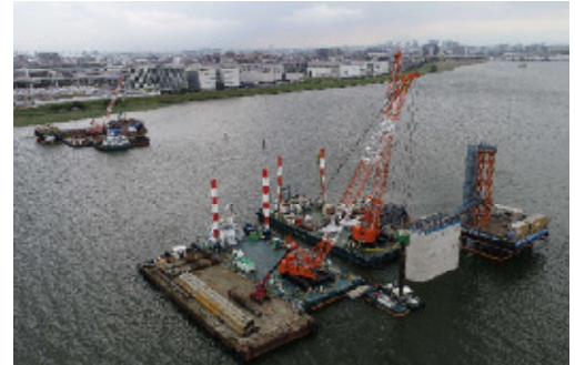
P4橋脚全景(鋼管矢板切断後)
