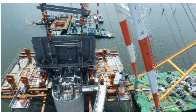
P4橋脚柱頭部架設状況
