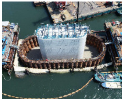
P4橋脚全景(鋼管矢板切断前)
