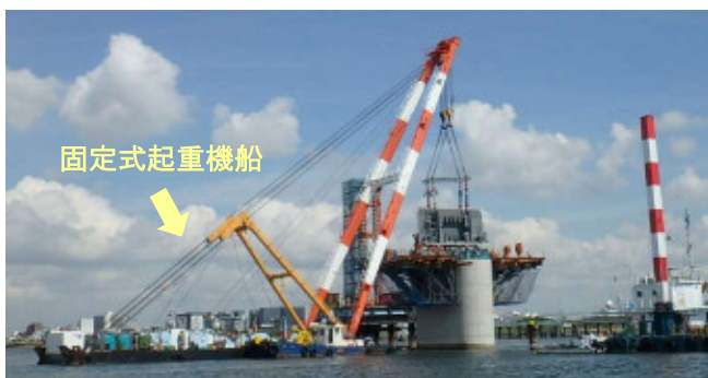
P4橋脚柱頭部架設状況
