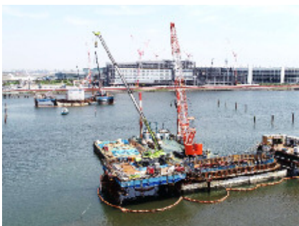
P3・P4橋脚全景 (川崎側から羽田空港側を望む)
