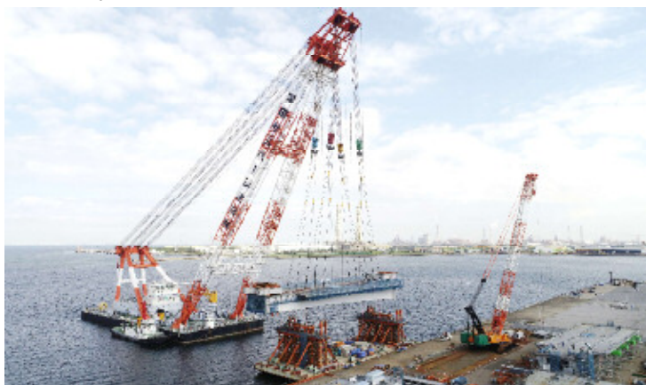
橋桁積込状況 (千葉県富津市)
