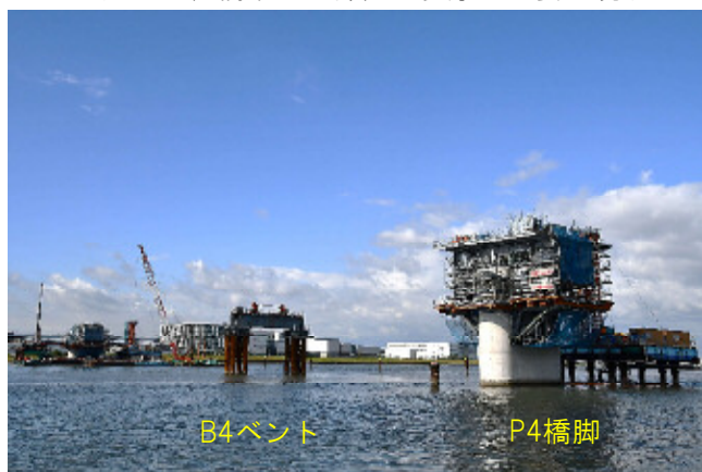
架設前 (B4ベントーP4橋脚) 全景
