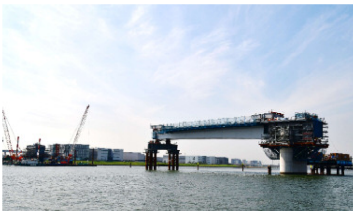
橋桁架設完了
