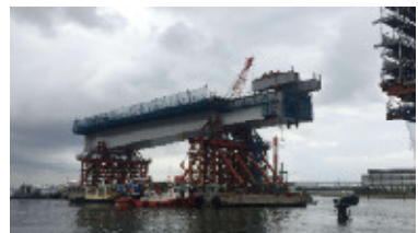
台船一括架設工法
