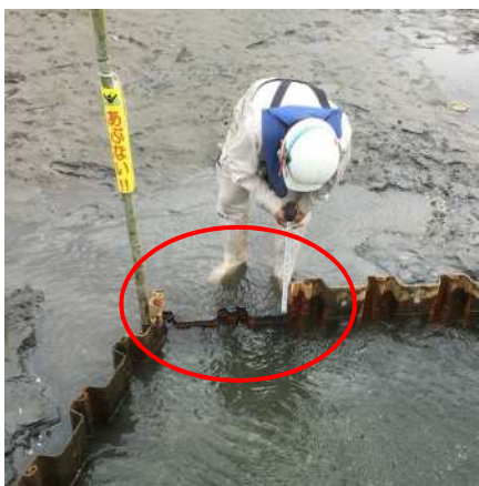
図 2.2.3-7 矢板打下げ状況(帯水対策)
