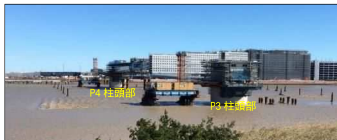
東日本台風通過時状況
