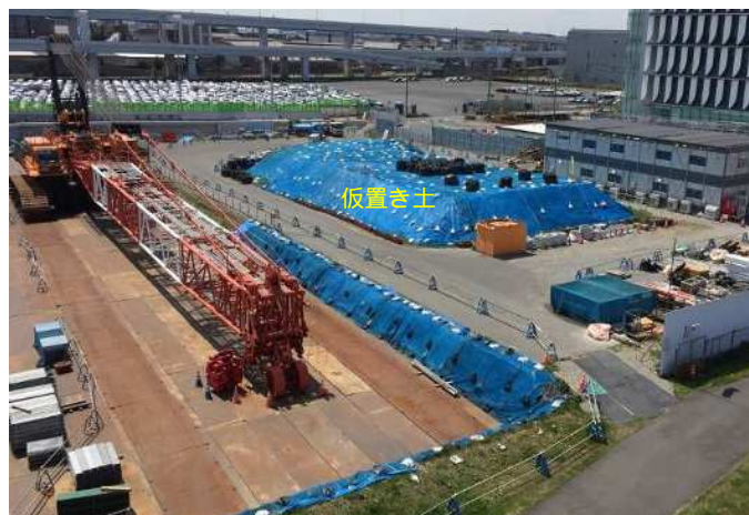
図 2.2.2.3-41 仮置き土ブルーシート養生
