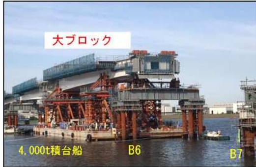
大ブロック台船架設
