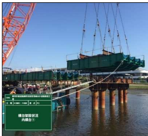
作業構台設置状況 (H30.6.5)
