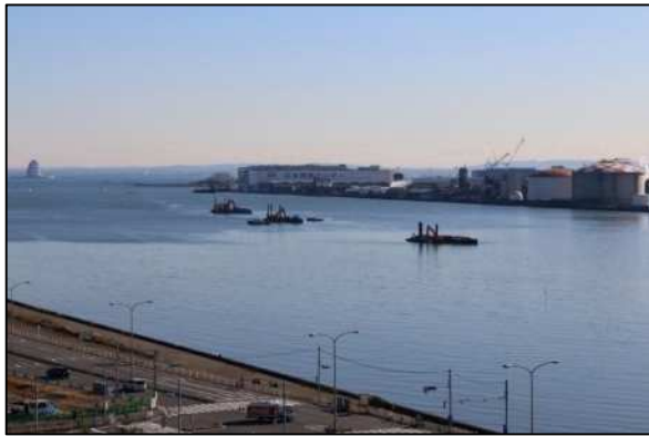
航路部の浚渫状況
