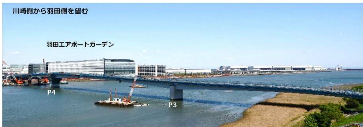
ベント設備撤去状況
