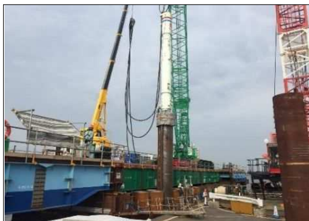
鋼管矢板打設状況 (P4 橋脚)
