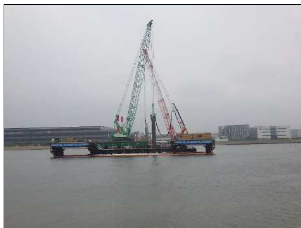
鋼管矢板打設状況全景
