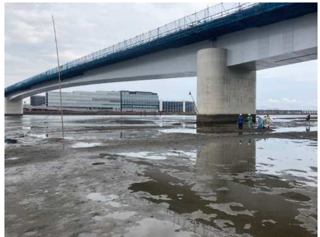
図 2.2.3-17 埋戻し完了全景
