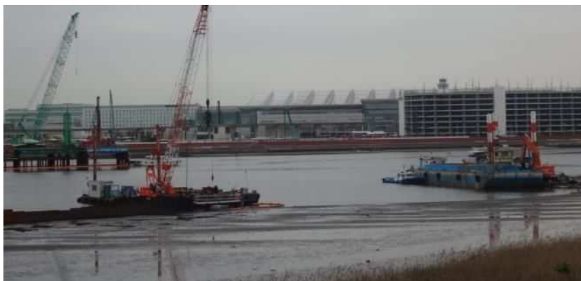
図 2.2.3-3 築造部浚渫状況
