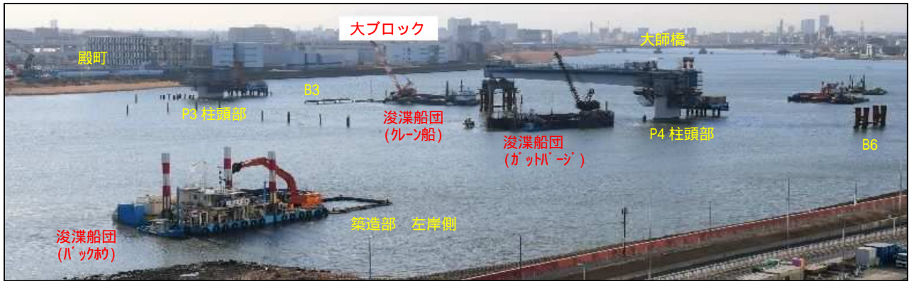
築造部(右岸・左岸)浚渫状況
