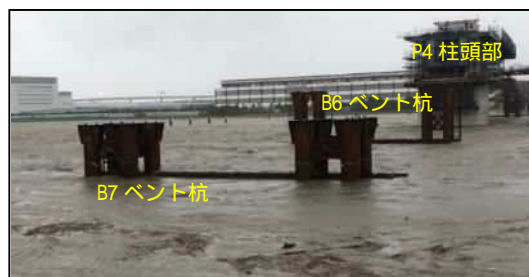
東日本台風通過時状況
