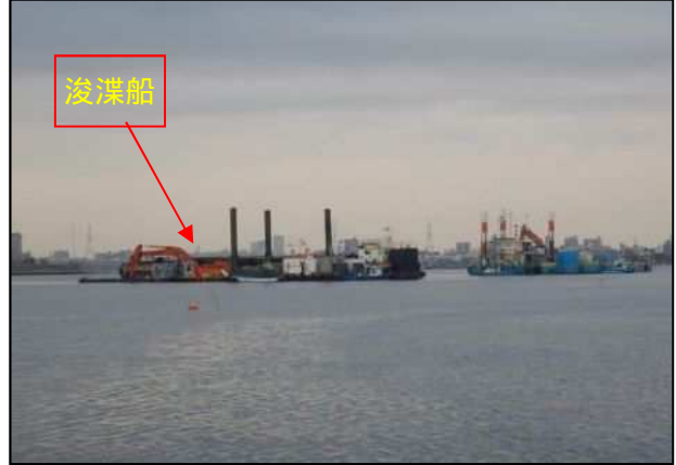
築造部の浚渫状況
