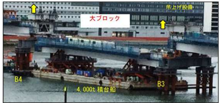
大ブロック一括吊上げ架設
