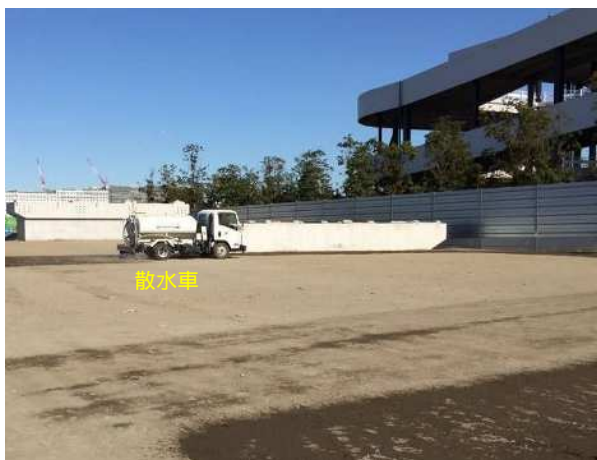
図 2.2.2.3-40 散水車による散水状況
