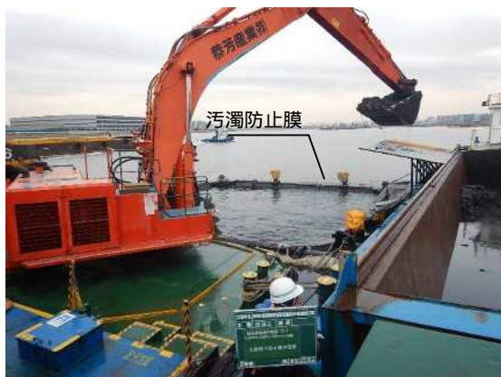
図 2.2.3-24 汚濁防止膜設置状況（浚渫時）
