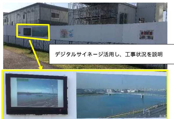
図 2.2.3-42 電光掲示板による説明状況(多摩川サイクリングロード沿い)
