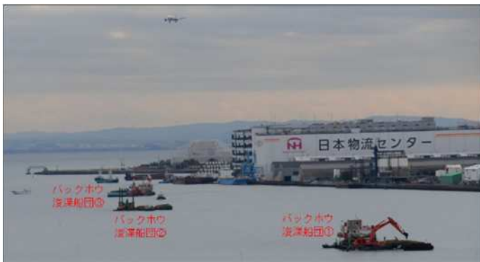
航路部浚渫状況
