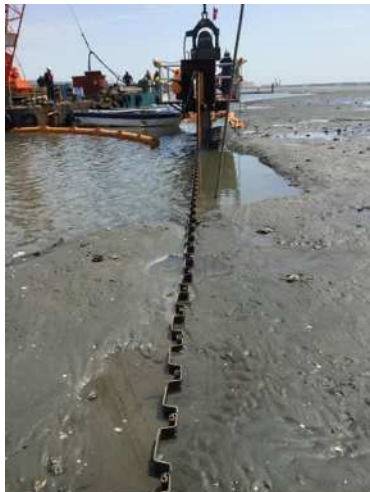
図 2.2.3-6 生態系保持空間の保護(仮設鋼矢板設置)の実施状況
