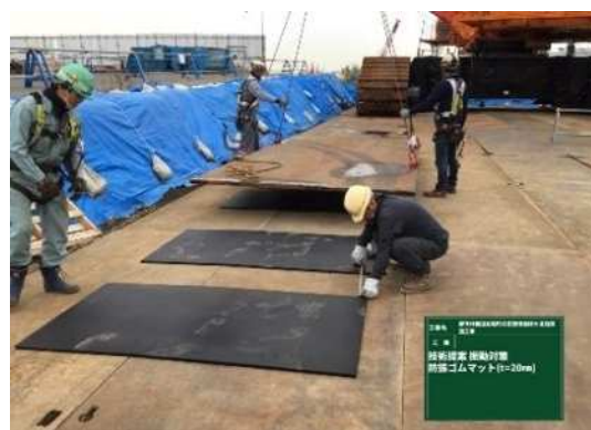
図 2.2.3-37 防振ゴムマット設置
