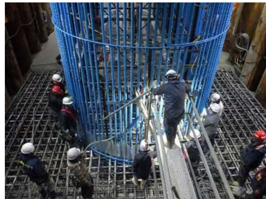
躯体コンクリート打設状況
