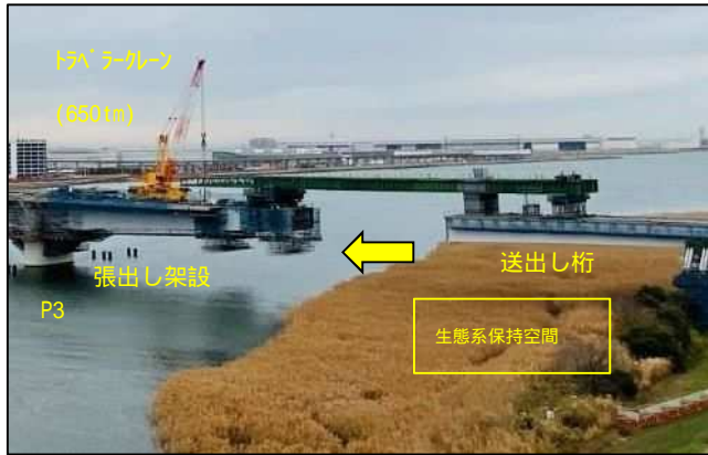
右岸側 張出し・送し架設
