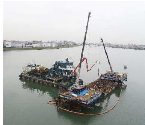
躯体コンクリート打設状況全景
