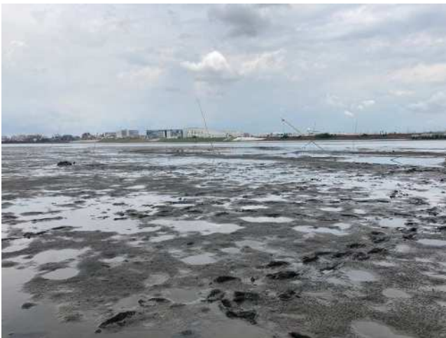
図 2.2.3-16 埋戻し完了全景
