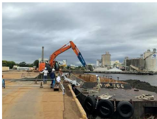
図 2.2.3-12 仮置き土砂積込状況
