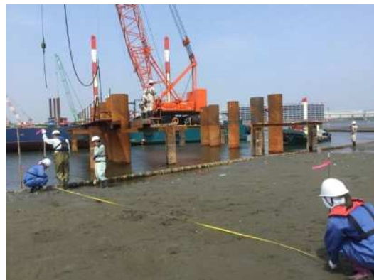
図 2.2.3-8 緩衝帯地形変化確認状況
