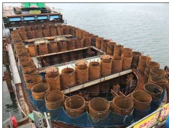
鋼管矢板打設完了 (P4 橋脚)
