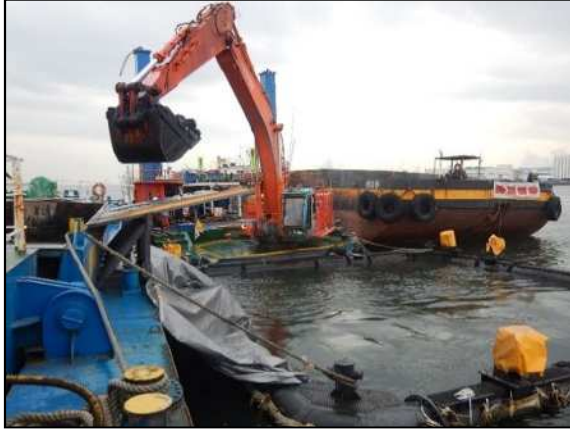
浚渫状況（近景）
