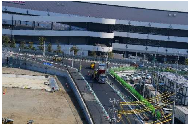
交差点部道路舗装状況
