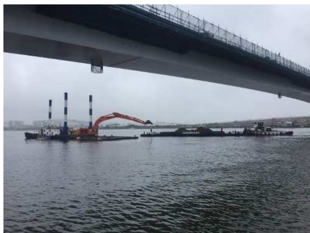
図 2.2.3-13 埋戻し土投入状況
