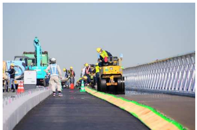
歩道舗装状況
