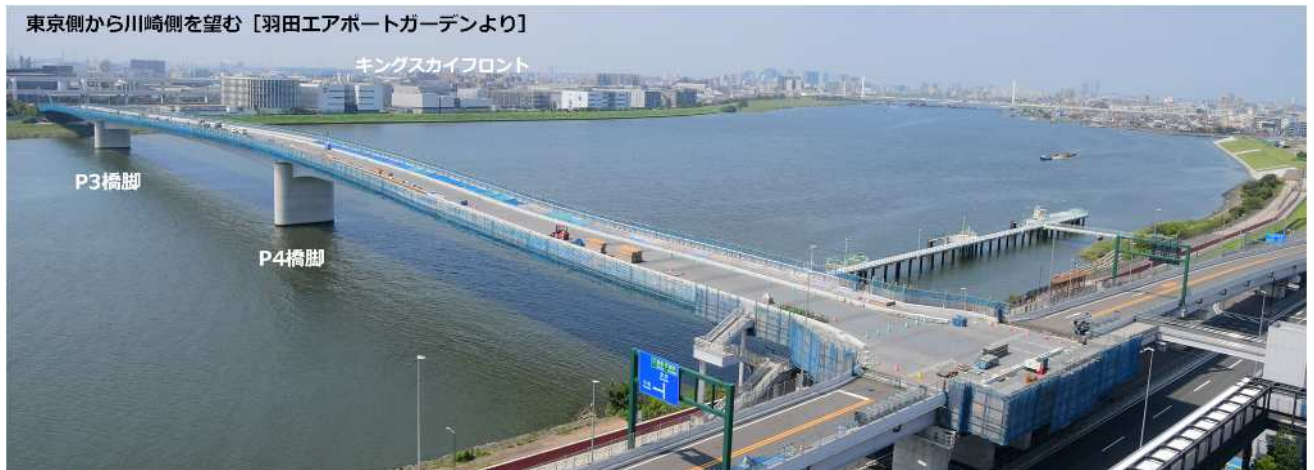
橋梁部地覆コンクリート実施状況
