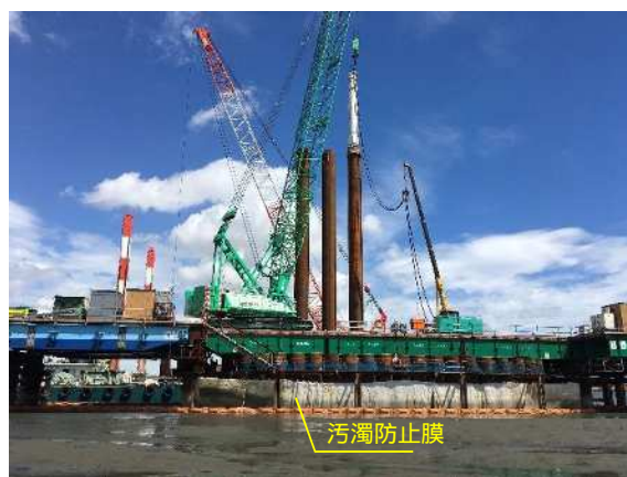
図 2.2.3-25 汚濁防止膜設置状況（鋼管矢板打設時）
