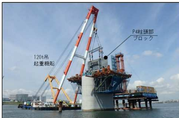
柱頭部 鋼桁据付
