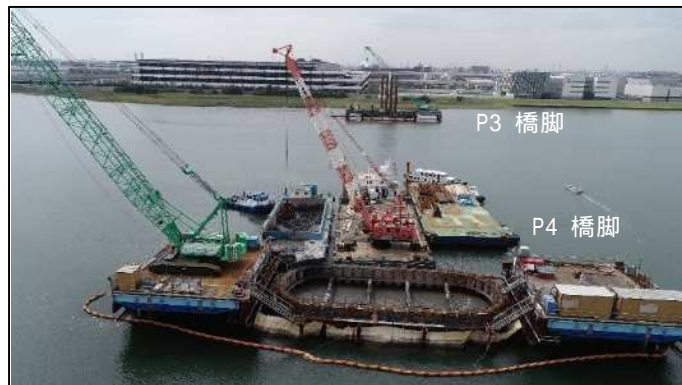
鋼管井筒内掘削状況 (P4 橋脚)
