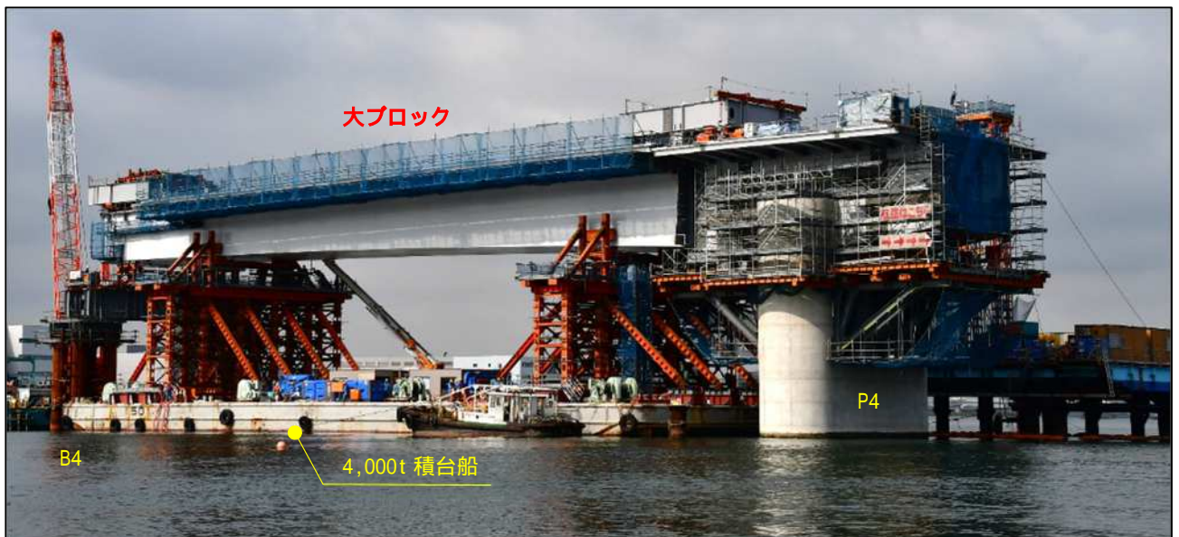
大ブロック台船架設
