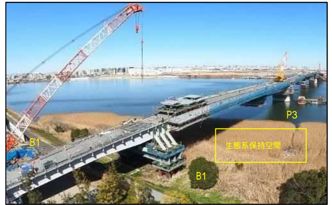
右岸側 側床版架設
