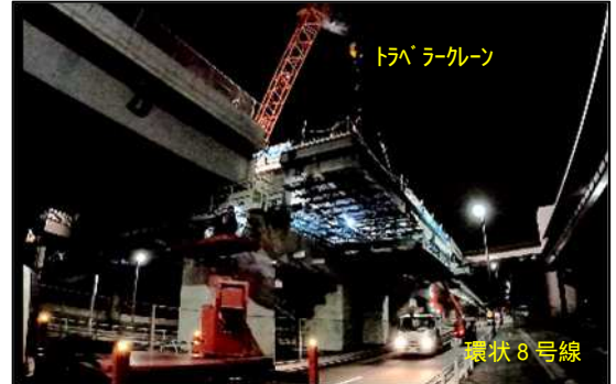
左岸側 張出し架設(夜間規制)
