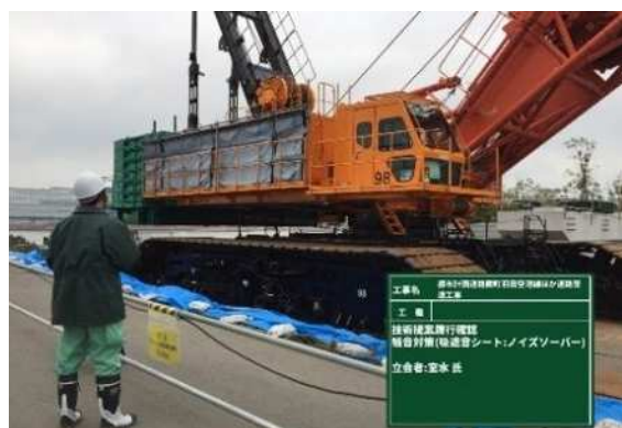
図 2.2.3-36 吸遮音シート設置
