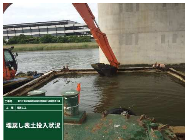
図 2.2.3-14 表土投入状況
