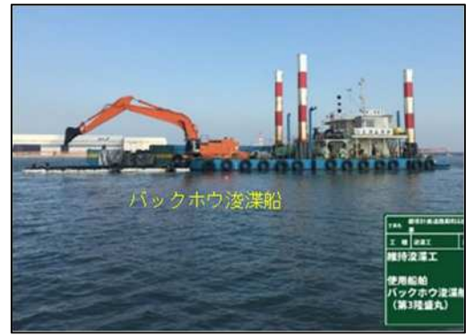
浚渫(バックホウ浚渫船)状況
