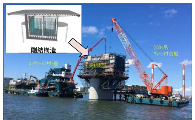
剛結部コンクリート打設
