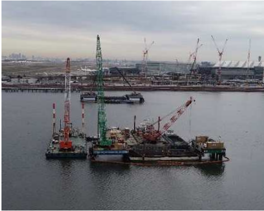
躯体構築状況全景
