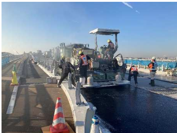
車道舗装状況
