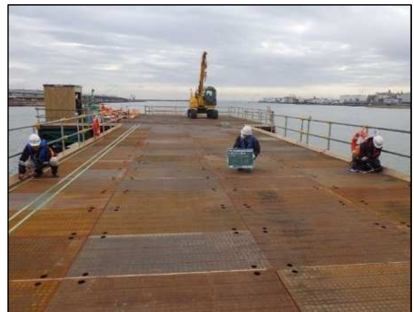
作業構台 組立完了全景
