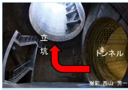
放流立坑内(トンネル接続部)
