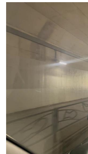
トンネル壁面撮影例
