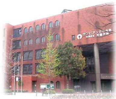
労働会館外観
