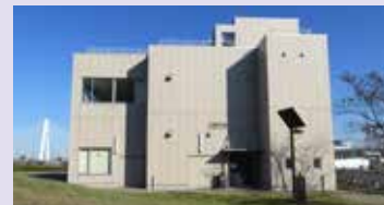
大師河原水防センター
