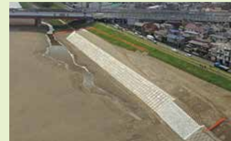
湧水空間を保持した、護岸工事施工直後
