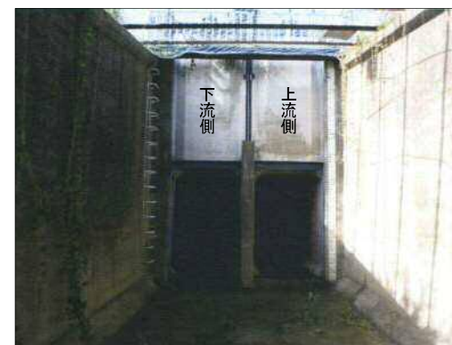
写真: 10月10日点検状況
