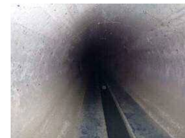
最下流部マンホールから上流
