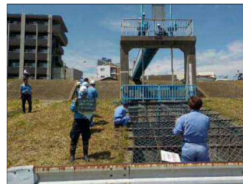
写真: 河川管理者による検査状況
