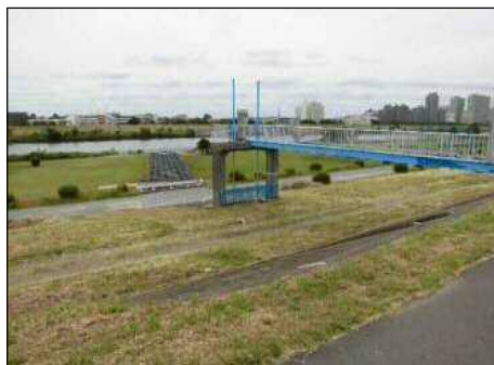
写真:排水樋管周辺状況(平常時)
