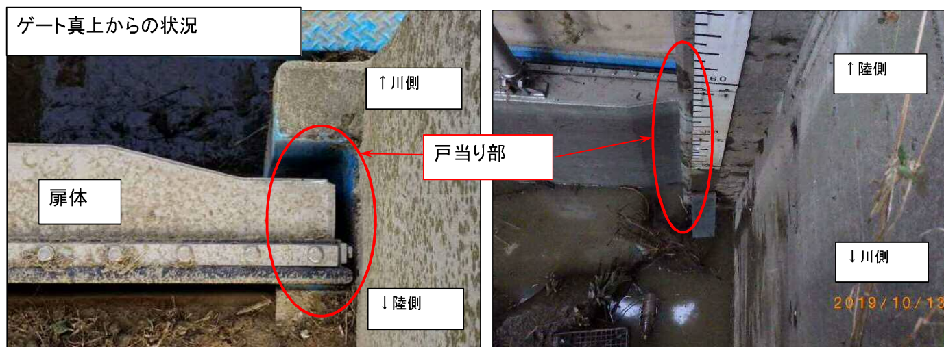
写真:扉体及び戸当り部
