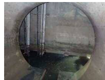
最下流部マンホール
