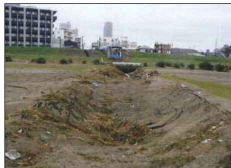
写真:排水樋管周辺状況(台風後)
