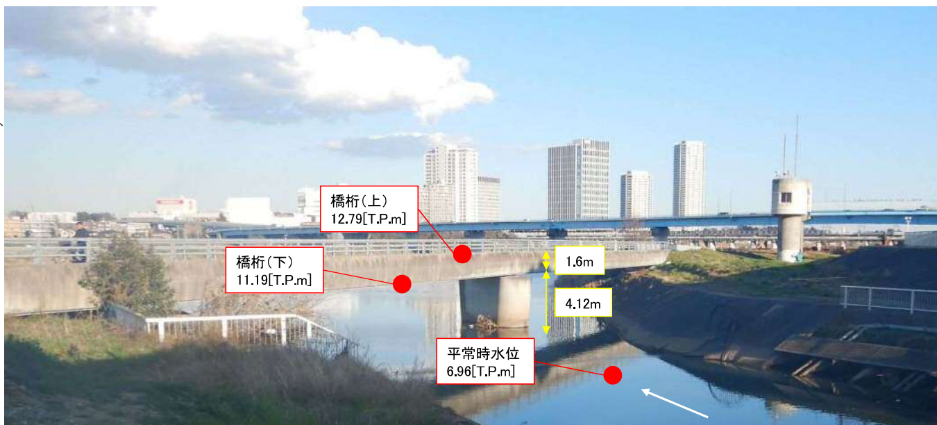
【平瀬川（多摩川合流部周辺の）の水位と緊急用河川敷道路橋の高さ】
