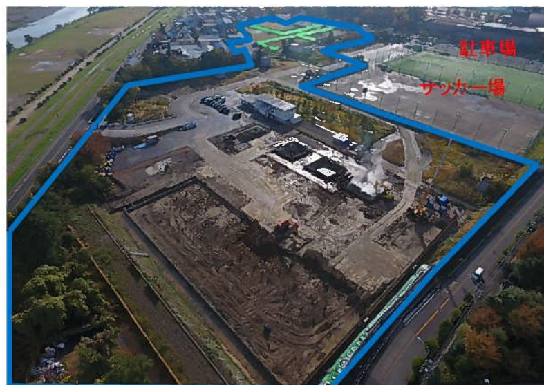
下水処理施設の施工状況
