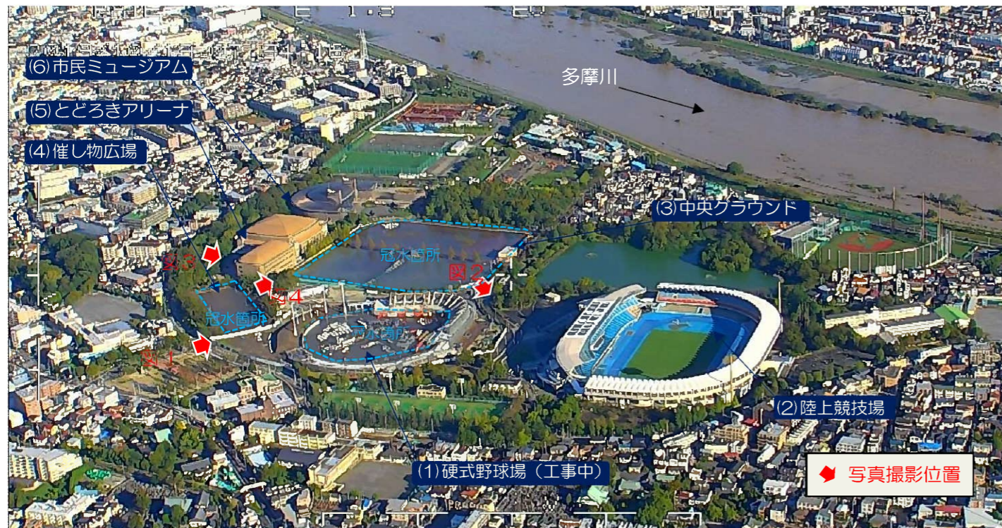
図5 令和元年10月13日 7:34頃 本市防災ヘリにより確認された状況
