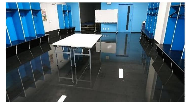
図7 メインスタンドの浸水状況
