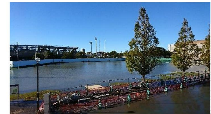
図8 中央グラウンドの冠水状況
