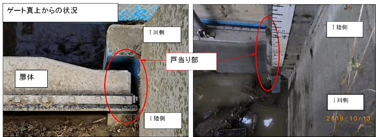
写真 9-2-3 山王排水樋管ゲートの戸当り部の状況
