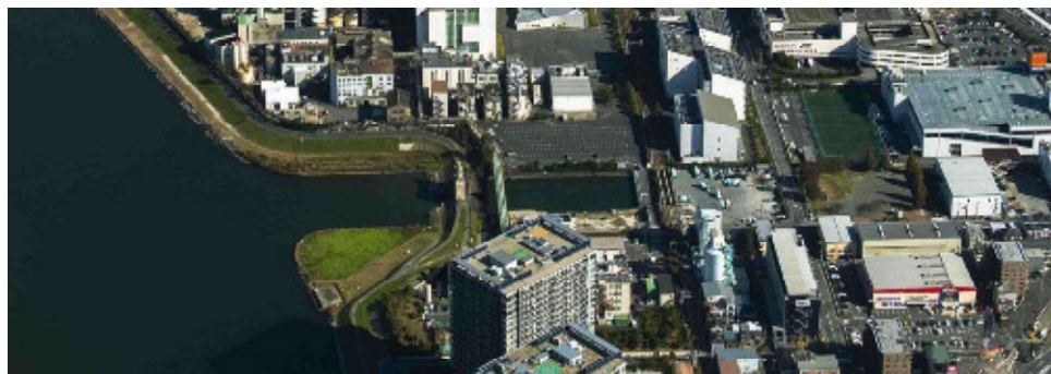
河港水門航空写真
