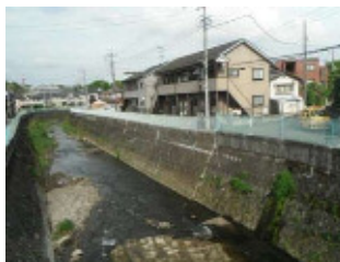
整備後の平瀬川
