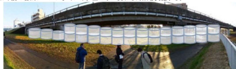
大型土のう設置イメージ
