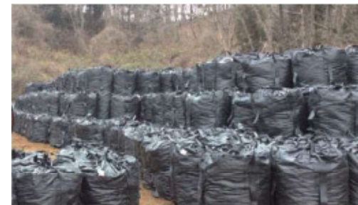
大型土のう(設置事例)
