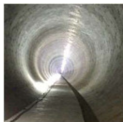
五反田川放水路
