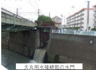
大丸用水接続部の水門
