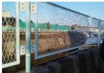
既存パラペット護岸
