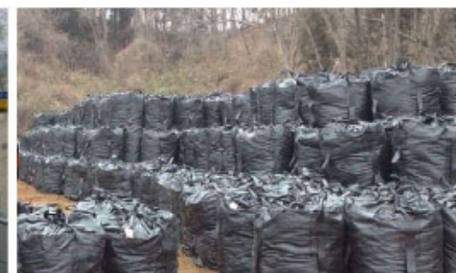
大型土のう（設置事例）
