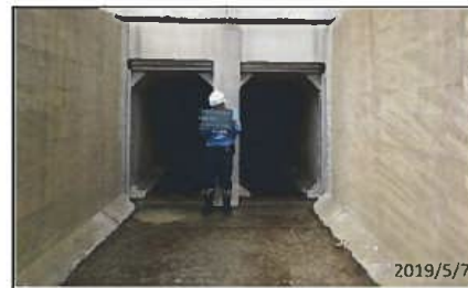
樋管ゲート写真
