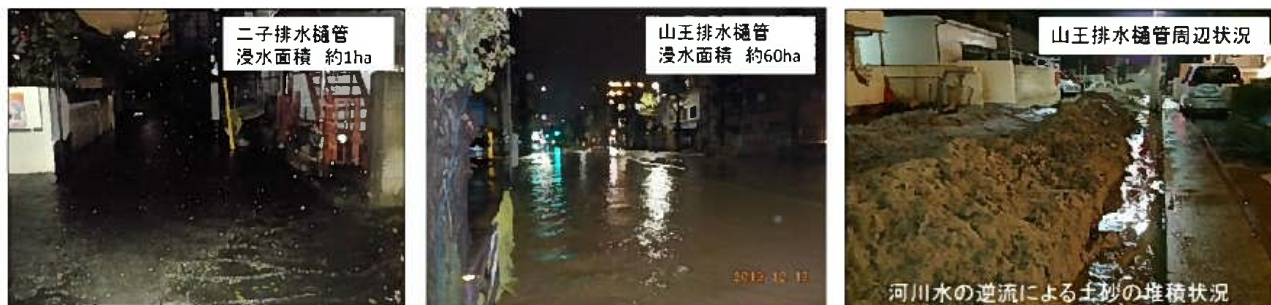
図 5-1 令和元年東日本台風による川崎市内の浸水状況
