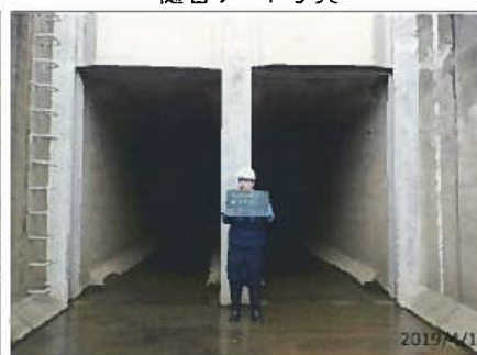
樋管ゲート写真
