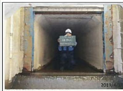
樋管ゲート写真
