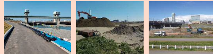
坂路仮復旧 上平間サッカー場 瀬田駐車場
