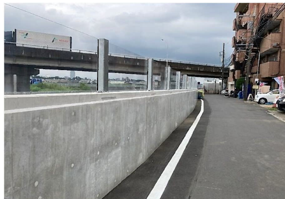
アクリル板（右岸側）の設置状況
