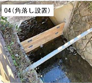
大丸用水水門計測状況
