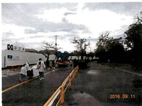
建設中野球場と陸上競技場の間
