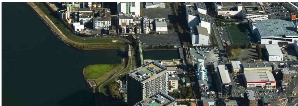
河港水門航空写真
