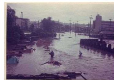
平瀬川の氾濫(高津区上作延/昭和51年)
