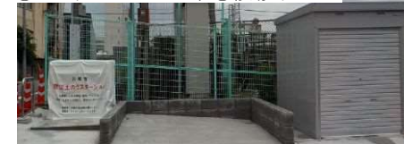
土のうステーション(写真左)・砂置き場(中央)・移動式ポンプ倉庫(右)
