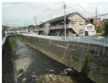
整備後の平瀬川
