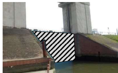
止水壁（水門前面）
