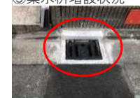
③集水樹増設状況
