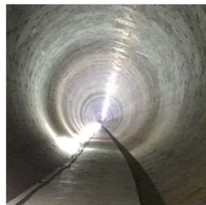
五反田川放水路
