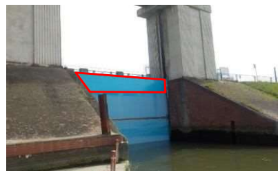
既設扉体嵩上げ
