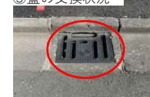
③蓋の交換状況
