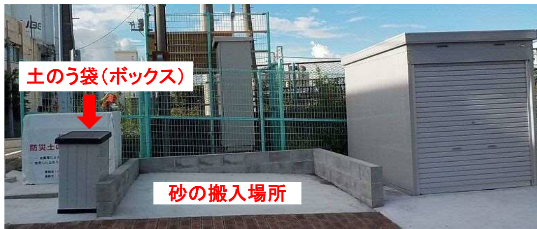
土のう袋と砂の搬入場所
