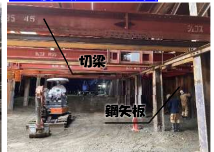
▽ 覆工板の下の写真
