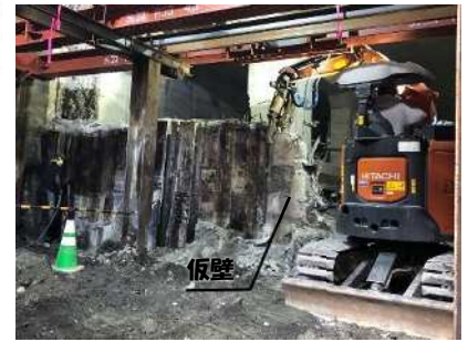
▽ 仮壁撤去状況の写真
