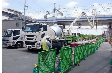
▽ 踏切直近の施工写真 (躯体(コンクリート)工事)
