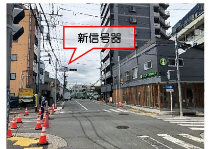
▽ 交差点部の施工写真
