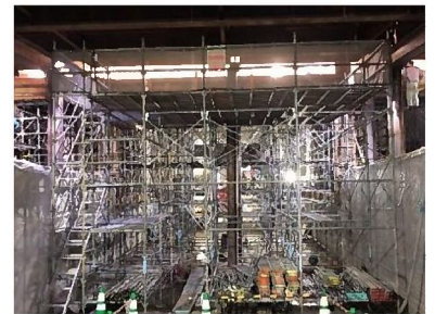
▽ 覆工板下の写真
