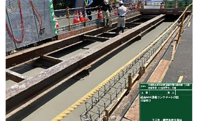
▽ 踏切直近の施工写真 (躯体(コンクリート)工事)
