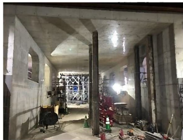
▽ 覆工板下の写真
