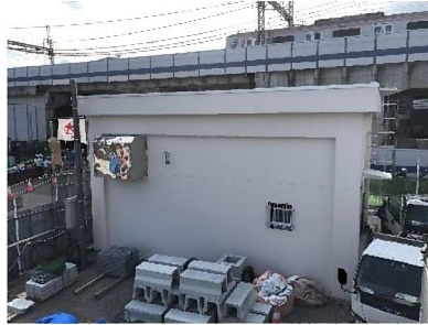
▽ ポンプ場の写真
