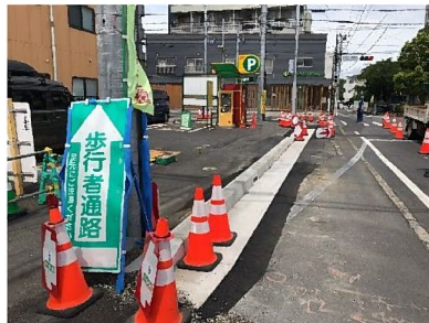
▽ 交差点部の施工写真
