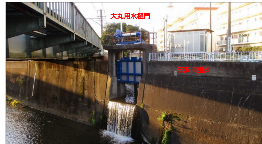
図 大丸用水樋門
