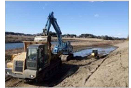
河道掘削の状況
