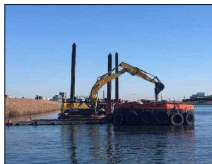
R2多摩川六郷 河道浚渫工事
