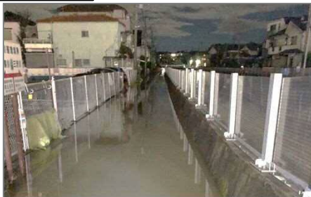
三沢川管理用通路の浸水状況
