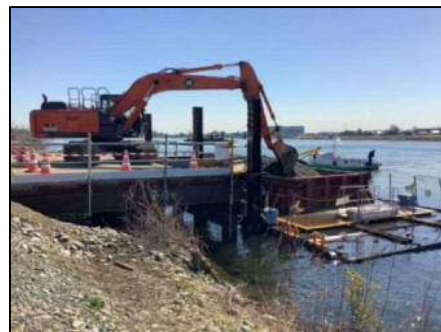
R2多摩川上河原堰上流 河道浚渫工事
