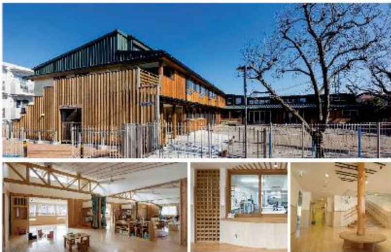
木造建築の事例（川崎市立生田保育園）
