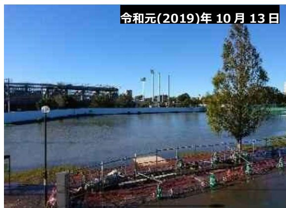
多目的広場等の冠水状況
