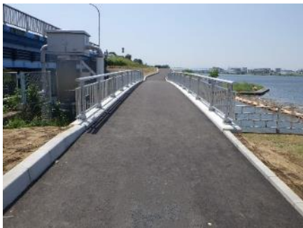
図 2-56 延伸整備（ピクニック橋）
