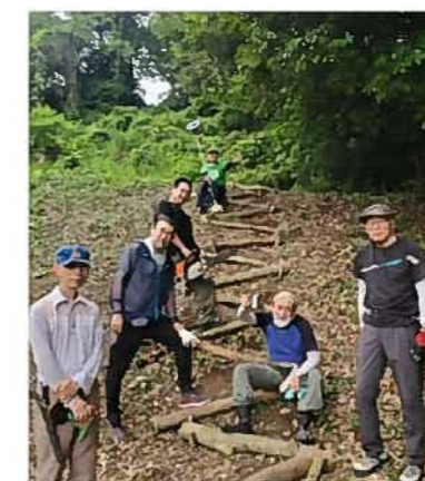
伐採木を活用した階段整備
