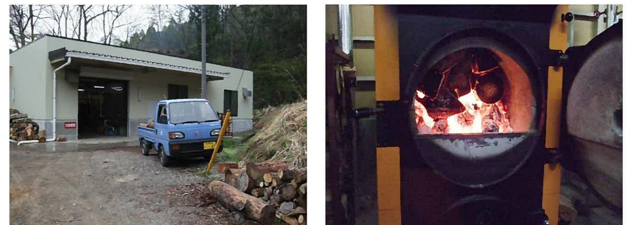
写真-4. 道志の湯のボイラー室（左）と薪ボイラー燃焼状況（右）（出典：資料 B）
