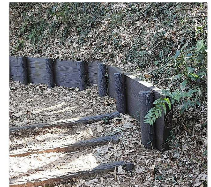
写真-15. 擬木資材を用いた更新状況
