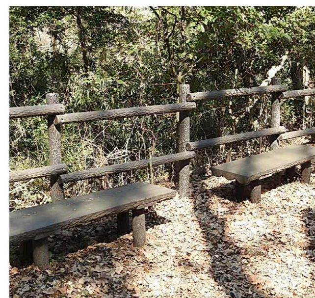
写真-15. 擬木資材を用いた更新状況
