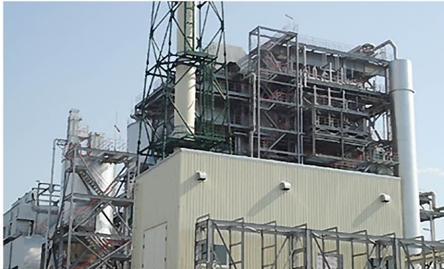
写真-5. 川崎バイオマス発電所では多様な燃料を使用できる循環流動層ボイラーを採用（出典：川崎バイオマス発電株式会社ホームページ https://www.kawasaki-biomass.jp/power-plant/ ）
