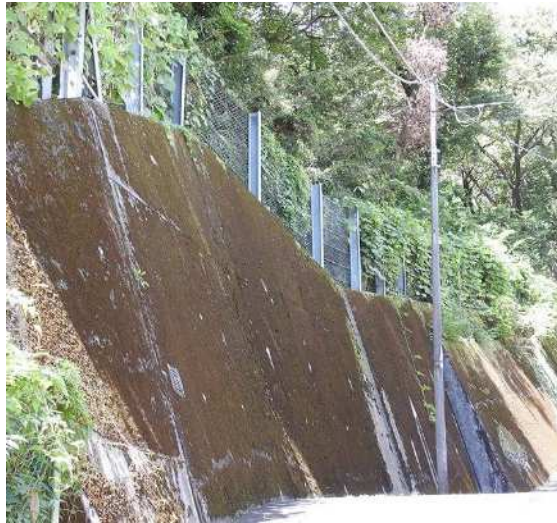
図表-15. 東生田2丁目地区、生田緑地の境界線に沿って昭和62年度急傾斜地崩壊対策工事として県により整備されたコンクリート張工（左）、コンクリート張工の上部に位置し隣接住宅に近接するナラ枯れ樹木（2022年9月6日撮影）（右）
