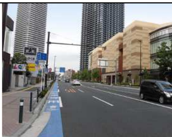
電線類の地中化
