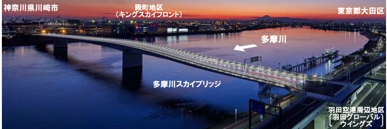
多摩川スカイブリッジ
