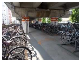
駐輪場（中原区）
