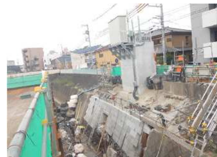
平瀬川水門の工事状況
