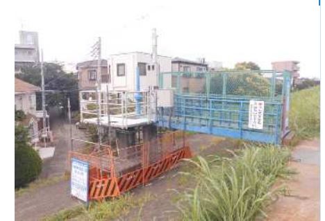
久地樋管の工事状況
