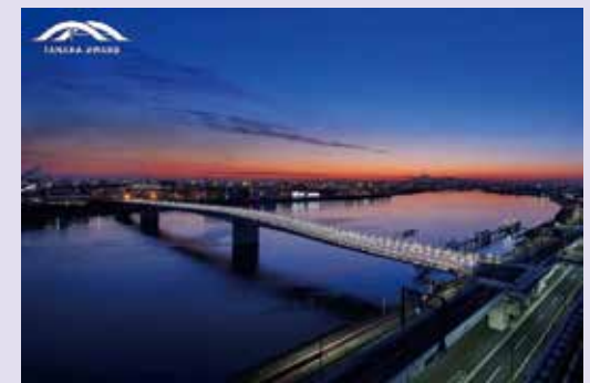
多摩川スカイブリッジ全景(左上:田中賞ロゴマーク)
