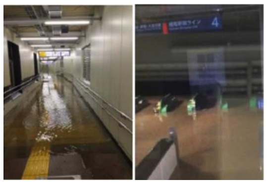
（JR武蔵小杉駅構内内水被害）
