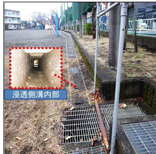
校庭貯留施設
