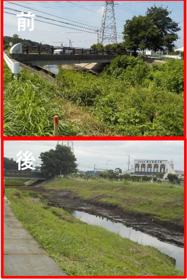
① 堆積土砂の撤去、樹木伐採、支障物撤去 樹木伐採
