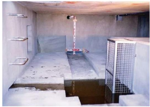
貯留施設 (地下貯留)
