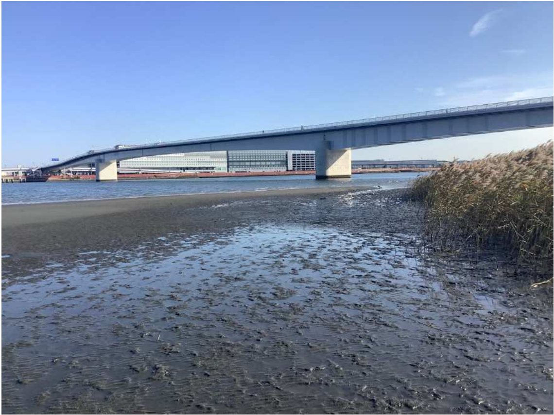
写真 1 完成した多摩川スカイブリッジ
