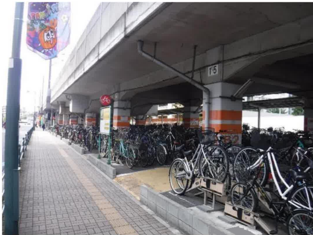
駐輪場 (JR南武線武蔵小杉駅～武蔵中原駅間)
