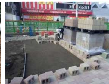
貯留浸透型舗装ブロック舗装
