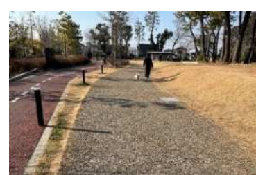
伐採木材の舗装材への活用 (世田谷区立 給田松の香公園)
