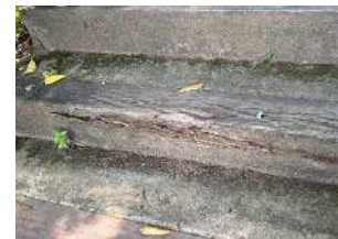
階段の腐食
