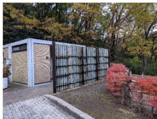
写真 16 現地のモウソウチクを利用した鉄砲垣 (2020年 11月14日)
