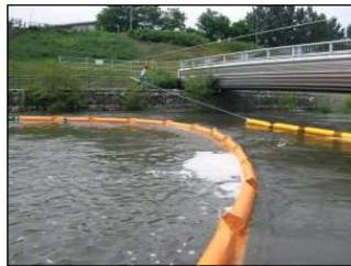
流出油拡散防止フェンス（施工例）
